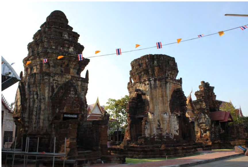
ภาพที่ 1.2 ปราสาทหินที่อยู่ภายในวัดกำแพงแลง จ.เพชรบุรี
