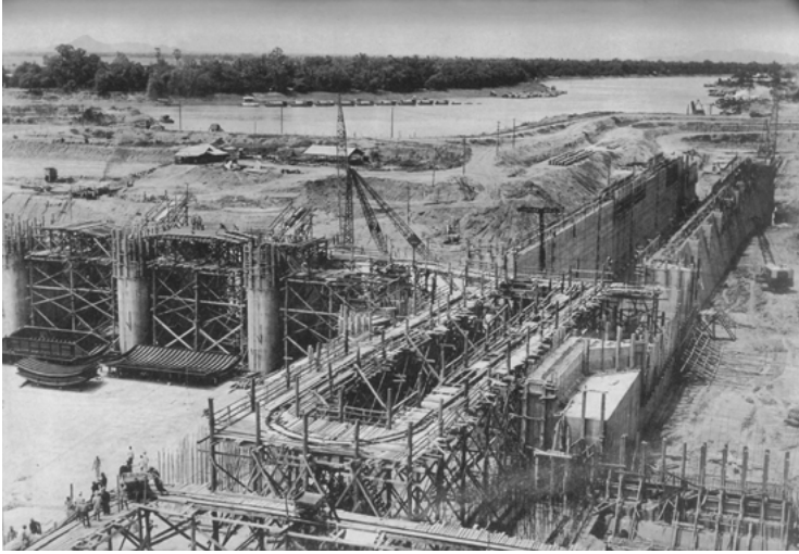
เขื่อนเจ้าพระยาขณะกำลังก่อสร้าง
